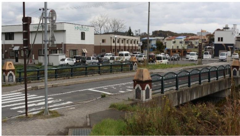
② 踏切から駅までの間 枇杷野橋
